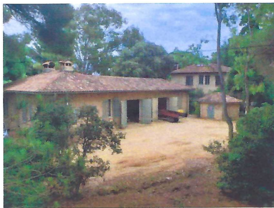
Bâtiments techniques et logements saisonniers
