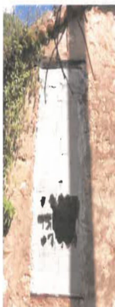
3 Ouverture murée - Façade Ouest (R+1)
