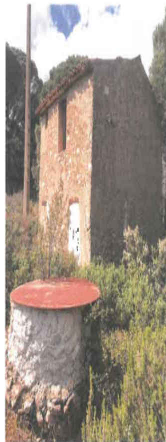
Puits au Sud Est
