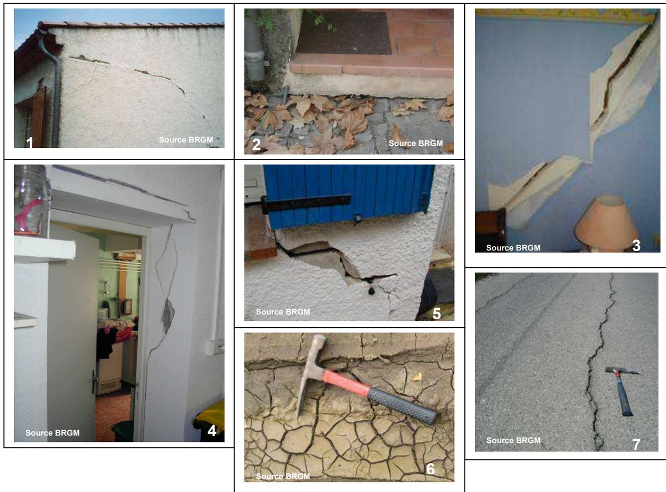
Illustrations : 1 – Angle de maison fissuré ; 2 – Décollement du seuil de la maison ; 3 – Fissuration d'une cloison intérieure ; 4 – Fissuration d'un linteau à l'intérieur ; 5 – Fissuration du soubassement extérieur ; 6 – Forme de dessiccation d'un sol argileux ; 7 – Fissuration de la chaussée.
