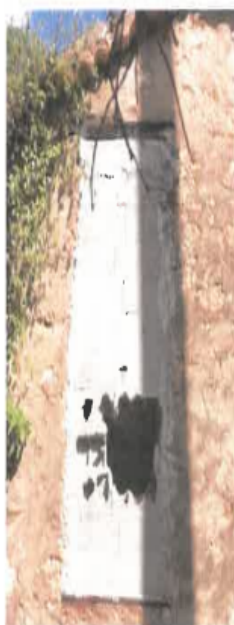
3 Ouverture murée - Façade Ouest (R+1)
