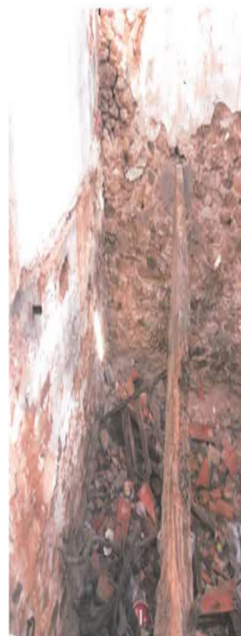
2 Angle Nord-Est (intérieur)
