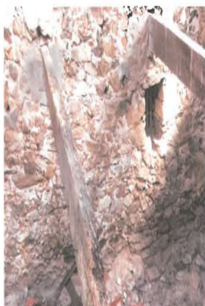
Détail poutre - Face Intérieure du Pignon Est
