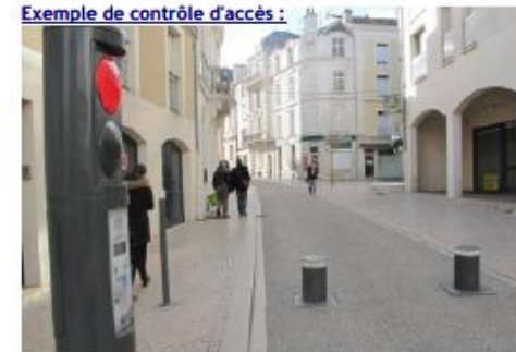
Exemple de contrôle d'accès :
