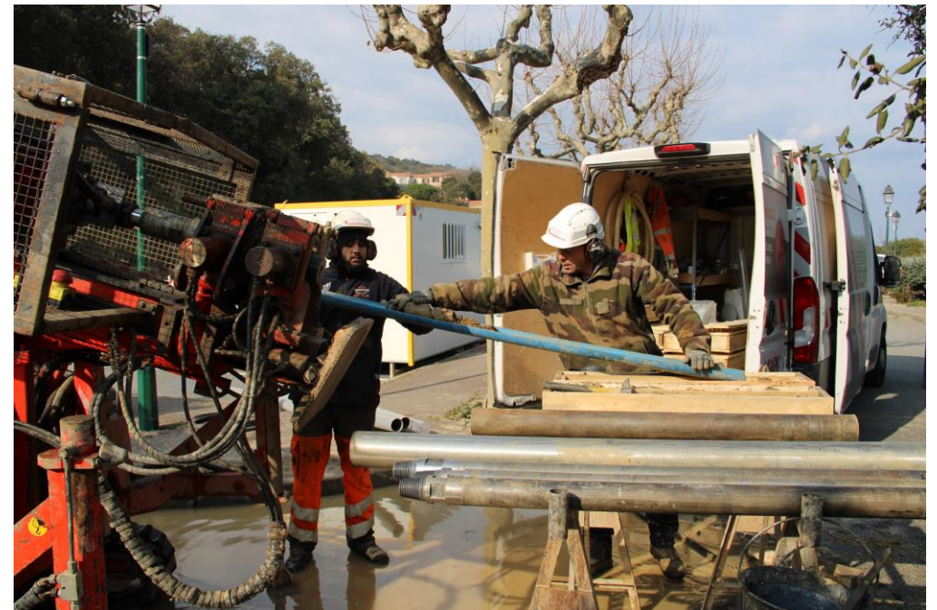
Sondages géotechniques en cours
